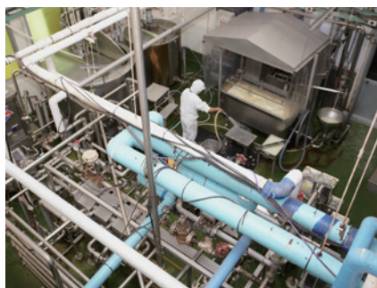
調合室の機械洗浄に水熱源エコキュートの温水を使用
